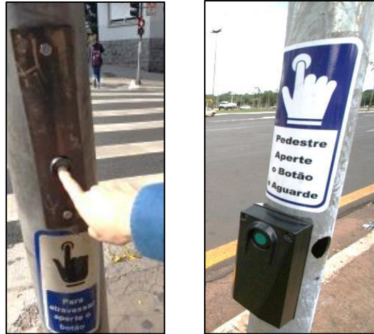
Figura 1: Exemplos de botoeiras para travessias de pedestres demandadas em São Paulo Fontes: foto à esquerda por Denise L. Lopes; foto à direita: arquivo CET
