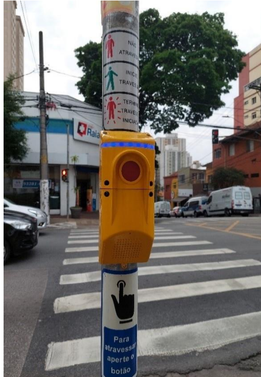
Figura 5 - Botoeira sonora instalada em coluna semafórica
