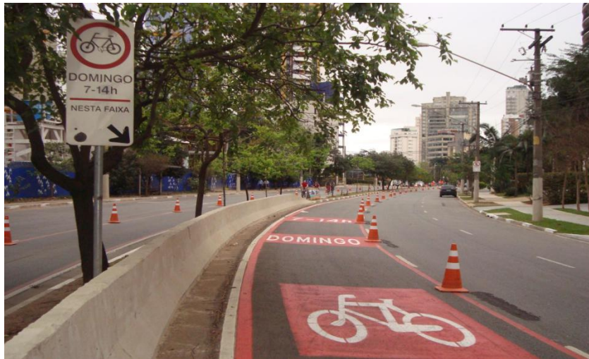
Figura 9: Av. Hélio Pelegrino - sinalização horizontal
