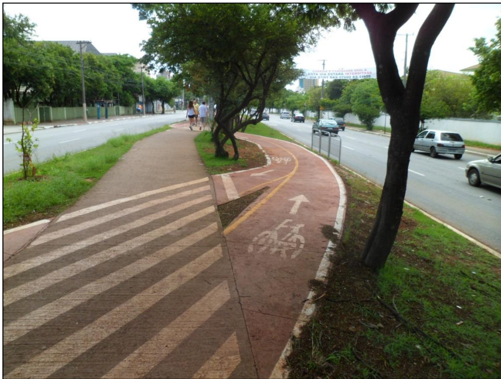
Aspectos da sinalização viária implantada na Av. Brás Leme
