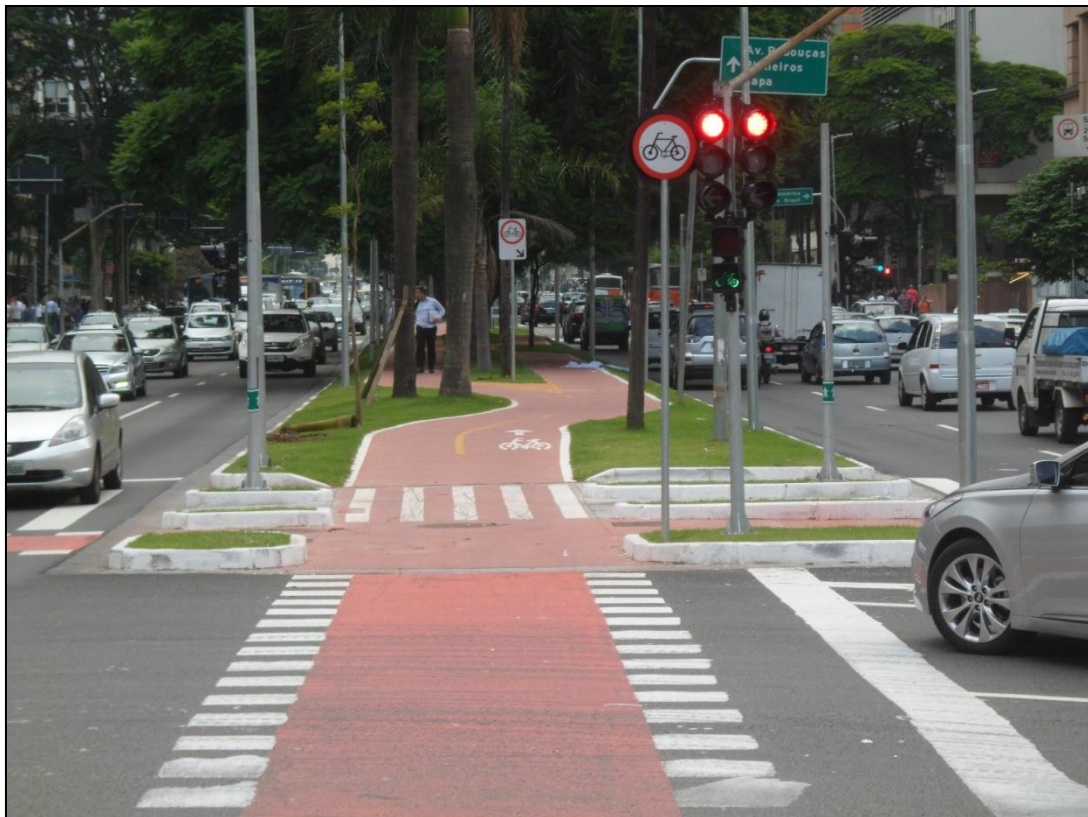
Aspectos da sinalização viária implantada na Av. Brigadeiro Faria Lima
