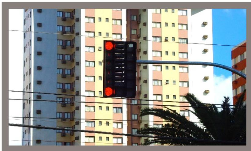
Figura A-15 – Grupo focal veicular com contagem regressiva em Maringá – PR
