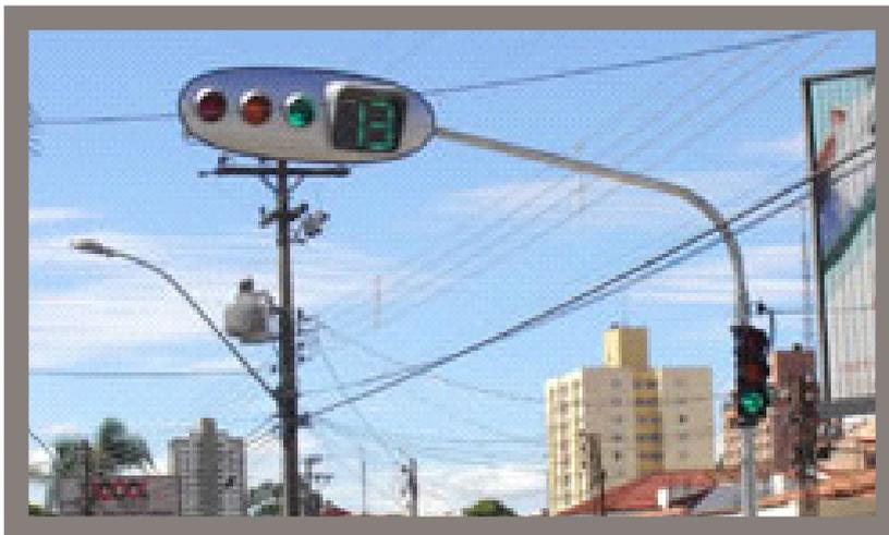
Figura A-19 – Grupo focal veicular com contagem regressiva na Av. Goiás, São Caetano do Sul – SP
