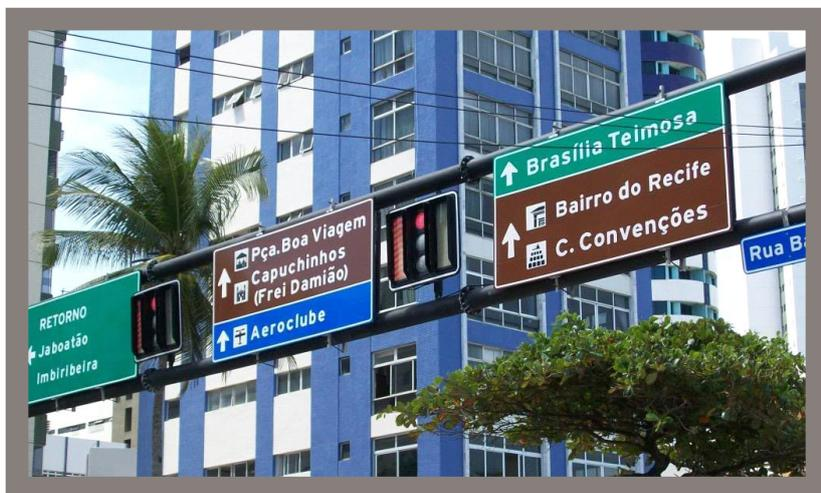
Figura A-17 – Grupo focal veicular com contagem regressiva, em pódio, junto a placas de orientação em Recife – PE
